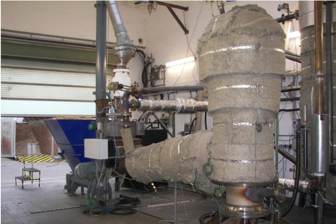
Abbildung 7.3 Versuchsanlage der Stadtwerke Rosenheim (© SWRO).
