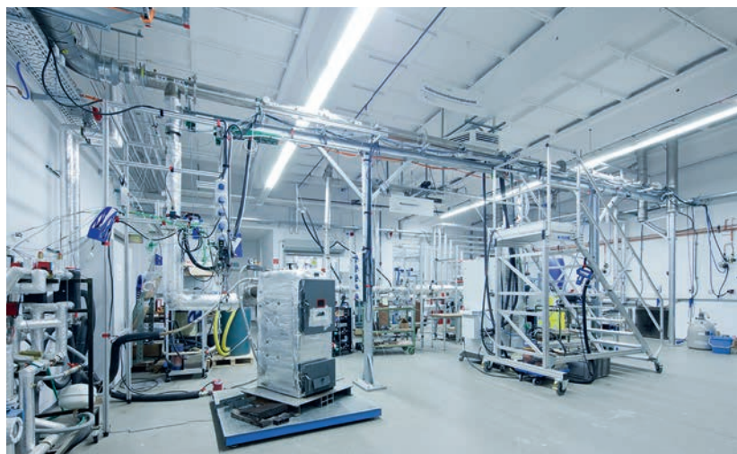
Abb. 59 Verbrennungstechnikum des DBFZ
