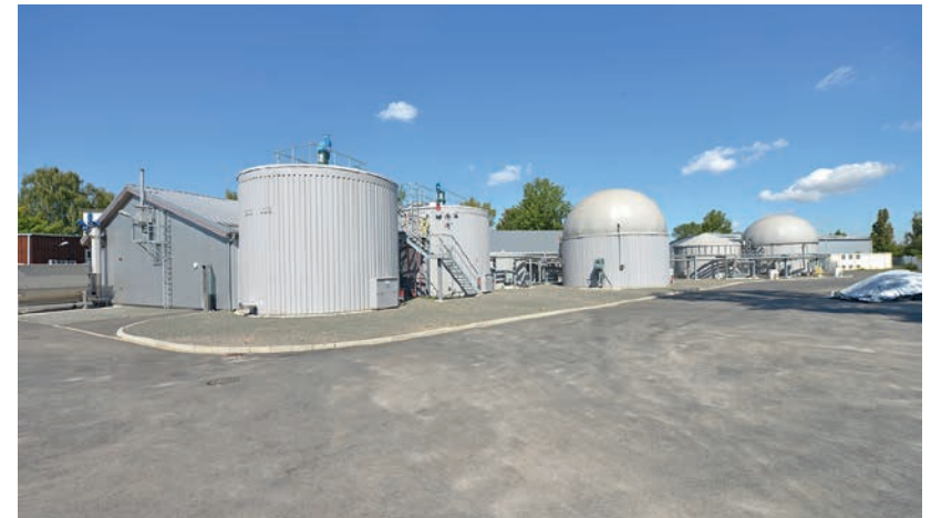
Abb. 53 Die Forschungsbiogasanlage des DBFZ
