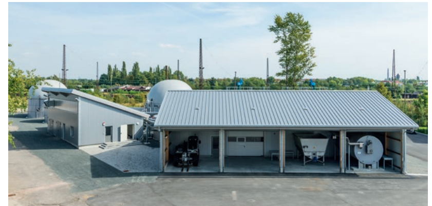
Abb. 60 Die Forschungsbiogasanlage des DBFZ
