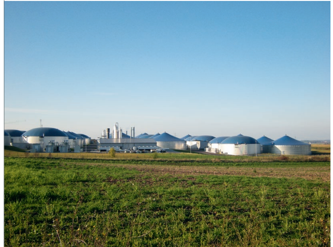
Abb. 31 Biogasaufbereitungsanlage mit Bereitstellung von Biomethan
