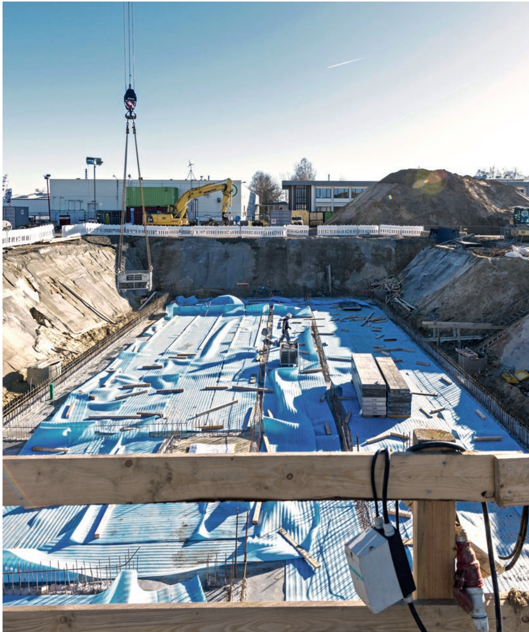
Abb. 57 Baugrube für den Neubau eines Büro- und Veranstaltungsgebäudes auf dem Gelände des DBFZ (Herbst 2016)
