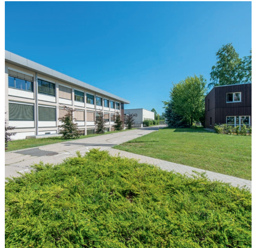
Abb. 47 Das Hauptgebäude des DBFZ (Haus 6) mit angrenzender Kindertagesstätte im Sommer 2016
