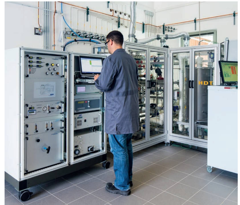
Abb. 36 Arbeiten im Kraftstofftechnikum des DBFZ
