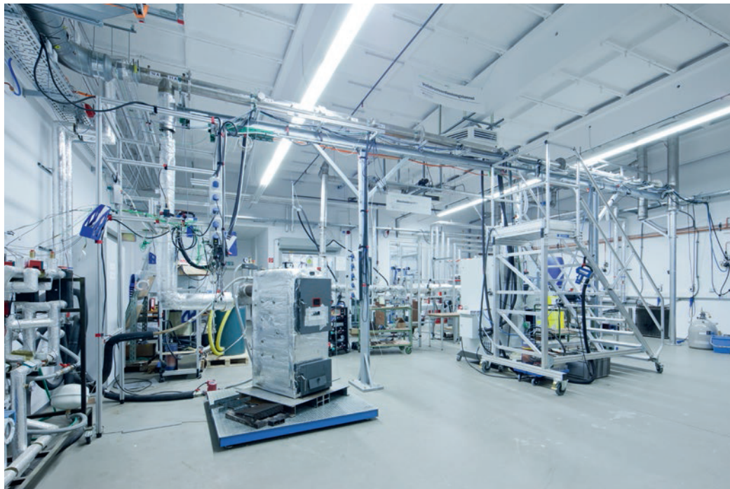
Abb. 46 Das Verbrennungstechnikum des DBFZ
