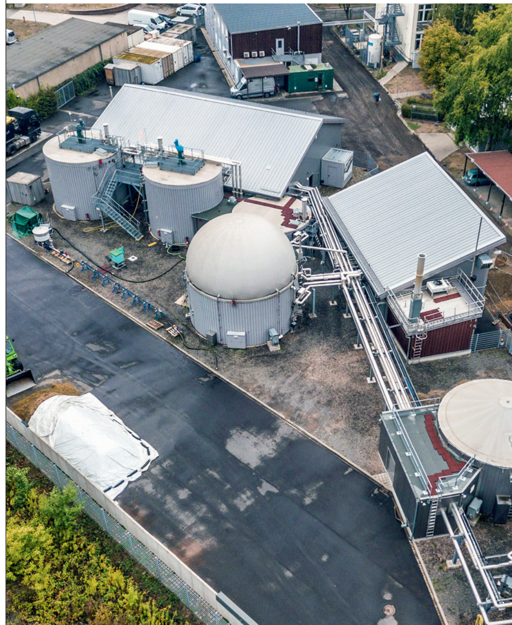
Abb. 42 Die Forschungsbiogasanlage des DBFZ
