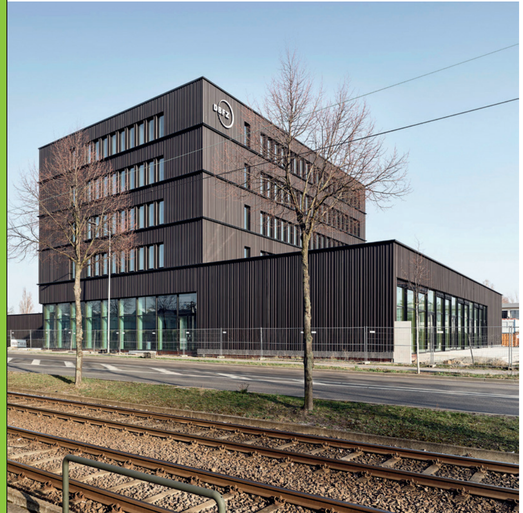
Abb. 44 Der Neubau des DBFZ im März 2019: Haus 1 inkl. neuer Veranstaltungshalle
