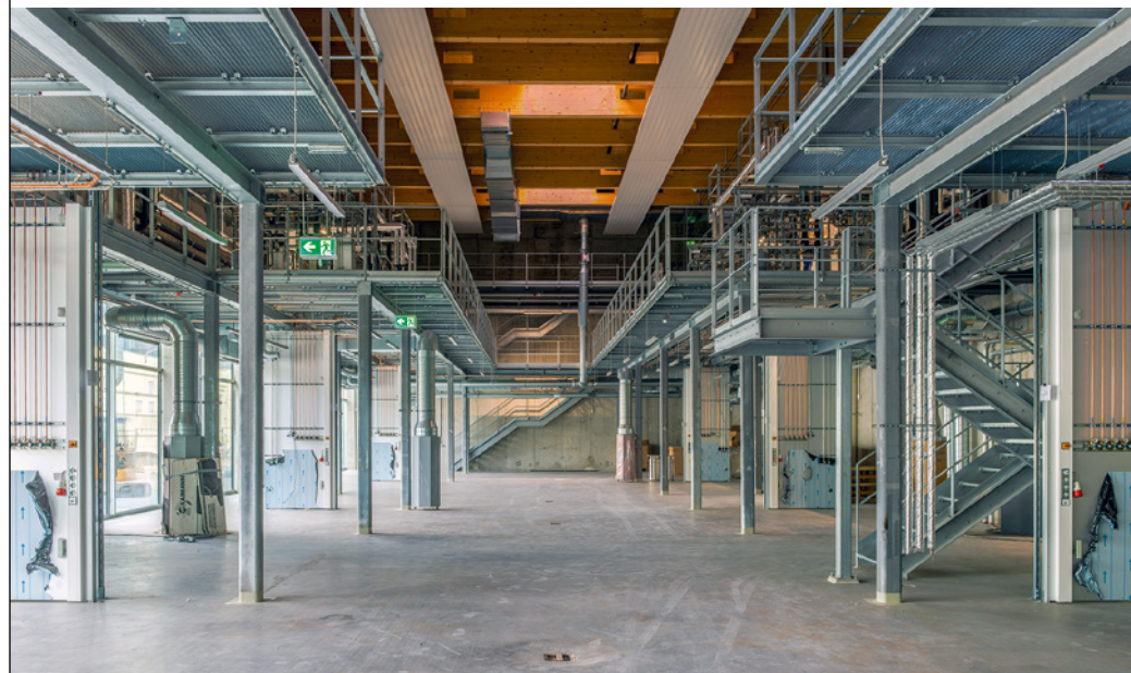
Abb. 42 Neues Tagungszentrum und Technikumshalle (Segment Thermo-chemische Konversion)
