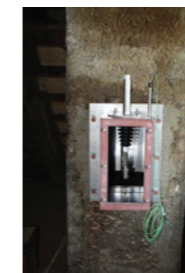
Gehäuse mit Isolator und Elektrode an Rahmen befestigen
