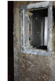
Einputzrahmen mit Mörtel befestigen
