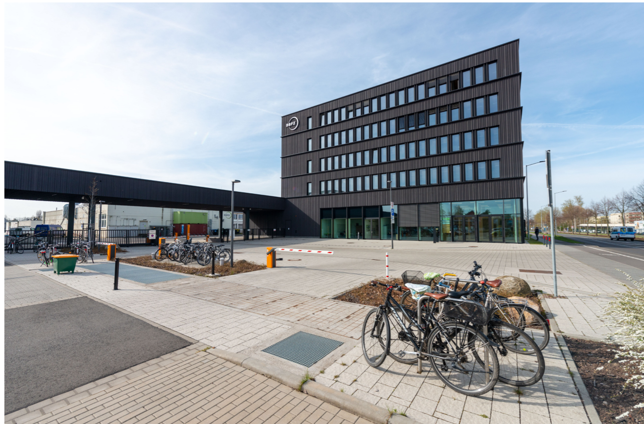
4. Fachgespräch Staubmessverfahren an Kleinfeuerungsanlagen
