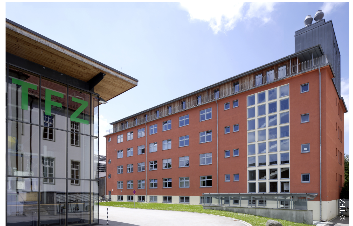
4. Fachgespräch Staubmessverfahren an Kleinfeuerungsanlagen
